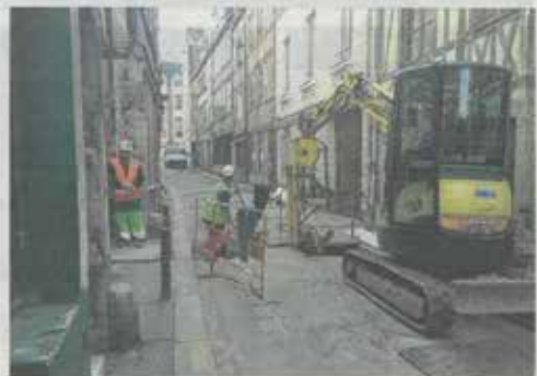
CHANTIER : des riverains de la rue Dinanderie satisfaits
